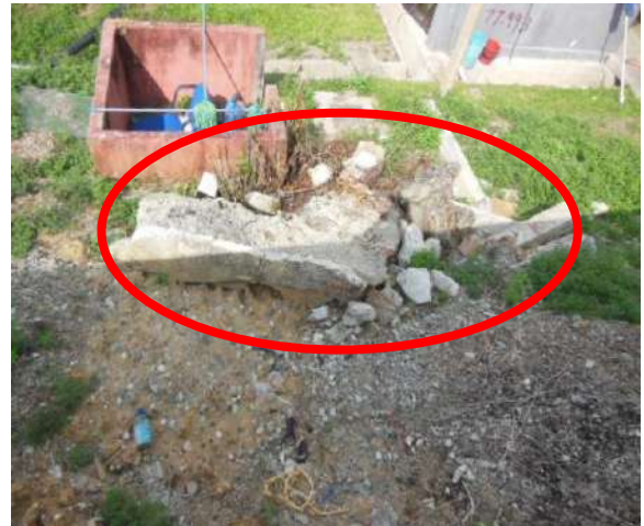
Sisa Bahan Binaan Tidak Diangkut Keluar Lokasi: Kawasan Lanskap, Hospital Kuala Lipis (Fasa II)
