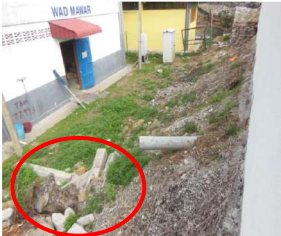
Sisa Bahan Binaan Tidak Diangkut Keluar Lokasi: Kawasan Lanskap, Hospital Kuala Lipis (Fasa II)
